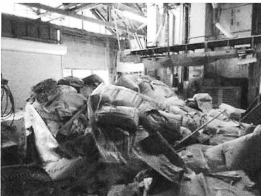
← スッポが外れ崩れ落ちた米袋 1000袋の一部と乾燥機
